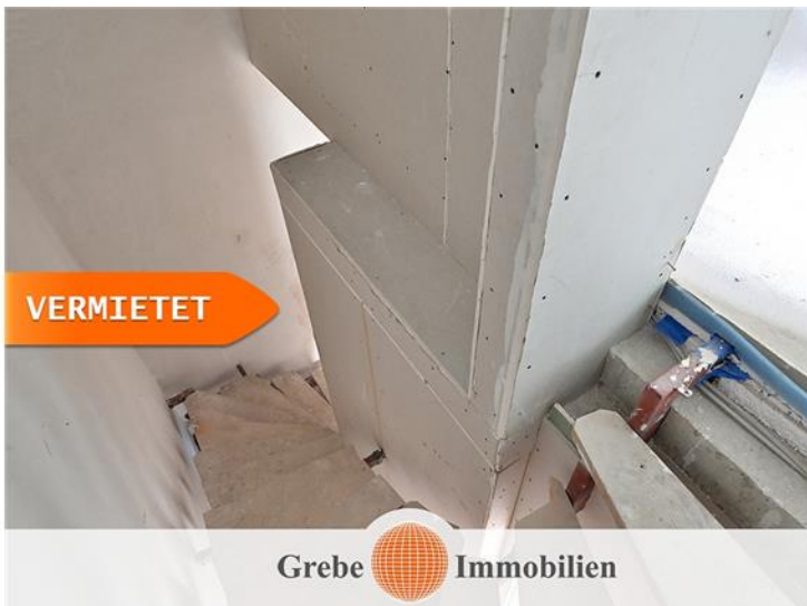
Zugang zum DG
